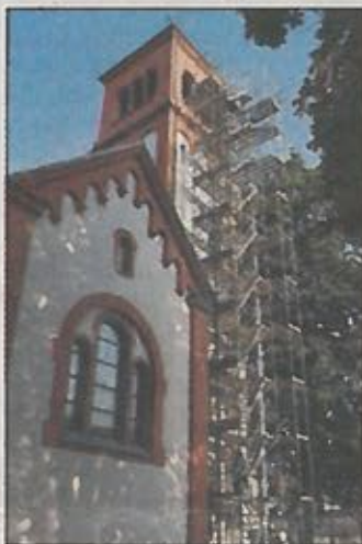
Vorbereitet: Das Gerüst am Glockenturm steht schon bereit.
